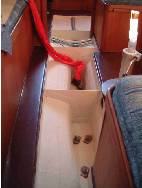
Bild 1. Tre stycken bottenstockar. Bilden tagen förifrån.
